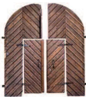
(1) Vanad värvikihid uksele enne nende eemaldamist. Fotod Peeter Säre (2) Fotomontaaž uksest pärast restaureerimist (3) Vanad värvikihid lähivaates
