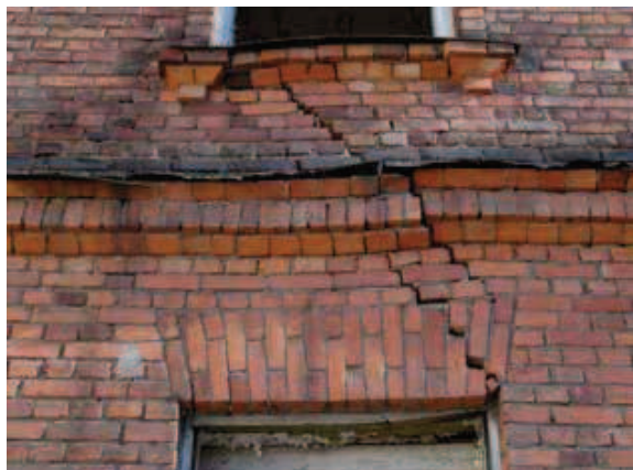
(1–2) Maja mõlemal pikemal küljel olid vundamendist katuseeni läbivad praod. Fotod Aavo Ossip (2015)
