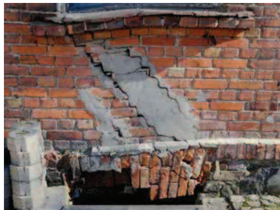
(1–2) Maja mõlemal pikemal küljel olid vundamendist katuseeni läbivad praod. Fotod Aavo Ossip (2015)
