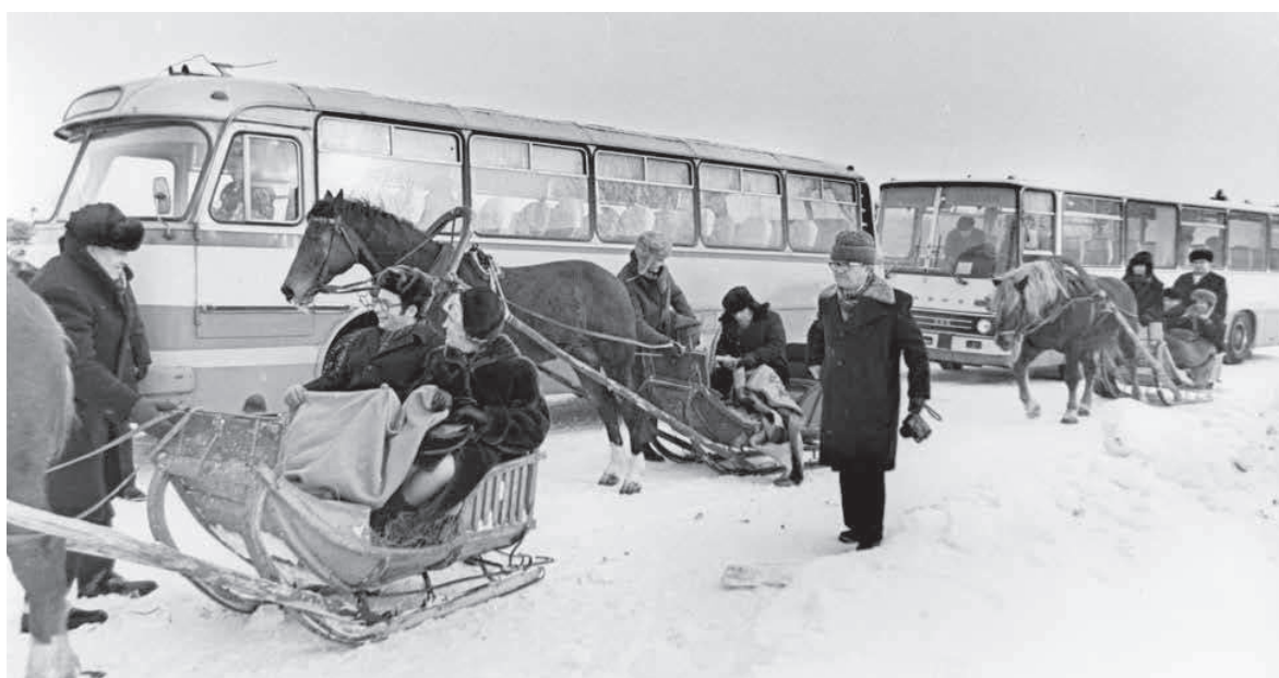
(1) Pooleliolev rehielamu 1977. a suvel. Fotod A. H. Tammsaare Muuseum Vargamäel (2) Ehitusmehed palgitöödel, vasakult Jaan Jürge ja Eino Kesa (3–4) Muuseumi avamine 29. jaanuaril 1978. Fotod A. H. Tammsaare majamuuseum
